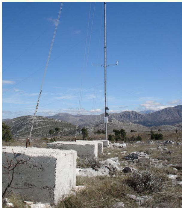
Fig. 7 Rudine - met mast foundations
