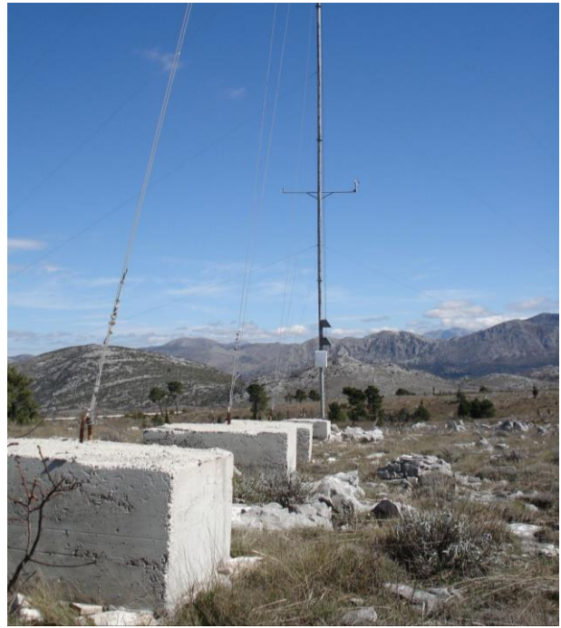
Fig. 7 Rudine - met mast foundations
